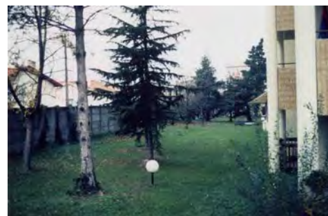
Tranchée sous terre végétale
